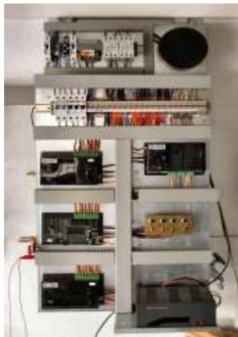
Im Garagenbereich ist die Schalttafel angeordnet. Von hier aus wird die gesamte Anlage versorgt. Die Verdrahtung war bei Projekteintritt bereits vorhanden. Die Ausführung scheint sehr gewissenhaft durchgeführt worden zu sein. Problematisch sind naturgemäß die überlangen Zuleitungen zu den Gleisabschnitten, welche HLU Übersprechprobleme verursachen.
